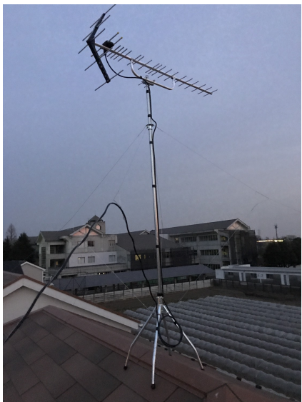
古河市鴻巣 エコスホーム様ご物件 屋根上設置 八木式アンテナ工事
