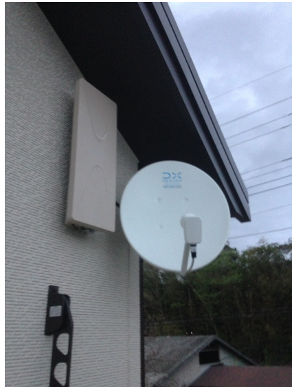
古河市女沼 壁面取付 デザインアンテナとBS/CSアンテナ工 事
