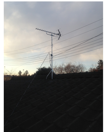
古河市東山田 染谷不動産様ご物件 屋根上設置 八木式アンテナ工事
