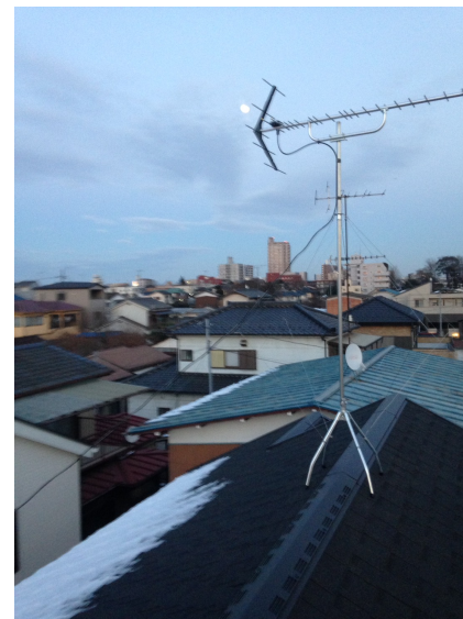
古河市錦町 エコスホーム住吉様ご紹介 屋根上設置 八木式アンテナ工事
