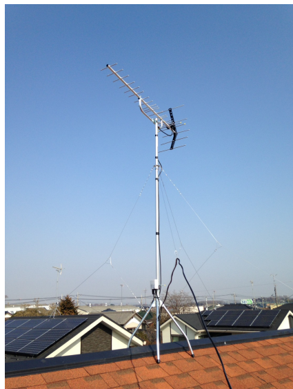
古河市松並 エコスホーム様ご物件 屋根上設置 八木式アンテナ工事
