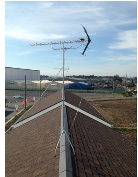
古河市坂間 ケイアイスター不動産様ご物件 地デジアンテナ屋根上工事
