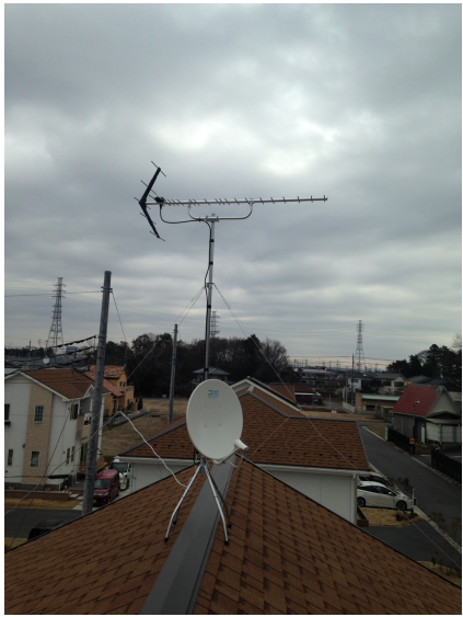
古河市下辺見 ケイアイスター様ご物件 屋根上設置 八木式アンテナとBS/CSアンテナ工
