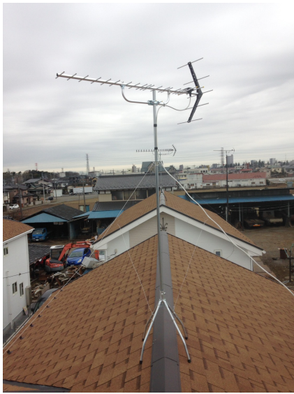
古河市上辺見 ハンディーホーム様ご物件 屋根上八木式アンテナ工事
