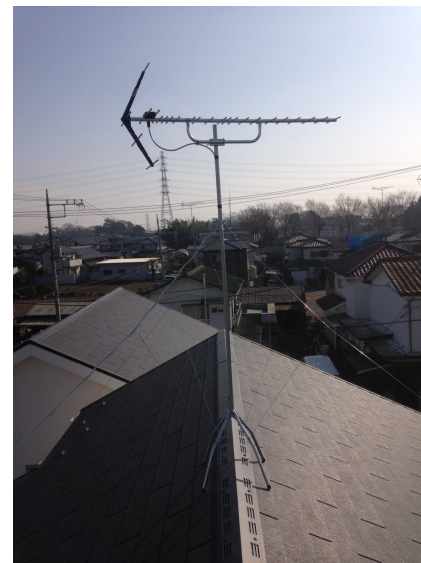
古河市諸川 エコスホーム様ご物件 屋根上設置 八木式アンテナ工事
